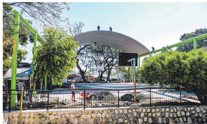
Damit der Basketballplatz auch im Schatten und während der Regenzeit genutzt werden kann, wird dieser aktuell überdacht.
