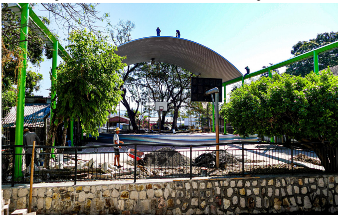
Die Arbeiter auf dem heißen Blechdach
