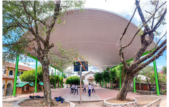
Das neue Dach überspannt den gesamten Basketballplatz
